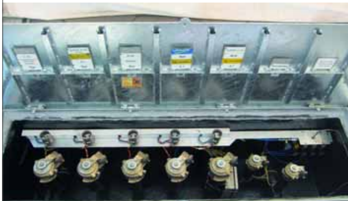
Fachgerechte Sanierung: Der Domschacht gehört zu den neuralgischen Punkten einer Tankstelle und sollte sich in einem einwandfreien Zustand befinden. (Foto: TAS Blank)
