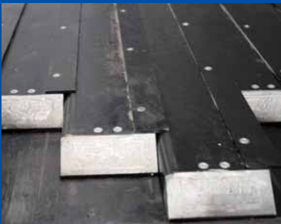
Flache Böden mit stählernen Profilen (Stapler überfahrbar)
