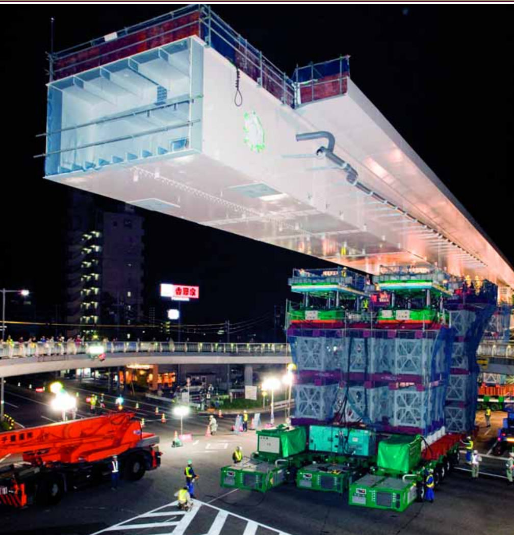
Ungewöhnlich hoher Schwerpunkt für die Selbstfahrmodule: Die gekoppelten Goldhofer-PST/ES-E positionieren sich unter der Brücke.
