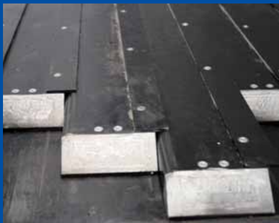
Flache Böden mit stählernen Profilen (Stapler überfahrbar)
