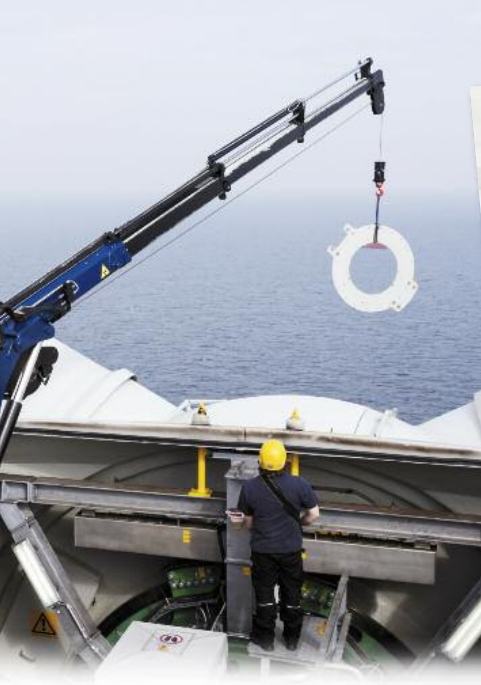
Hydraulisch angetriebene Seilwinde. (Fotos: Hersteller)
