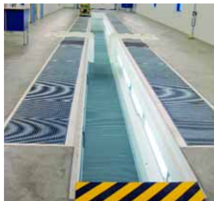
Effizienz und Sauberkeit: Die Umweltmontagegrube von Balzer.
