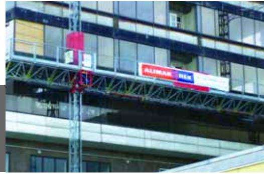
projekt an. Ob Verbreiterung oder Verlängerung der mastgeführten Kletterbühnen: Beides ist möglich. Durch vormontierte Ausschleibe-Systeme lassen sich die 1,50 m breiten Plattformen auf 2,50 m erweitern. Auch die Bühnenlänge ist variabel.
