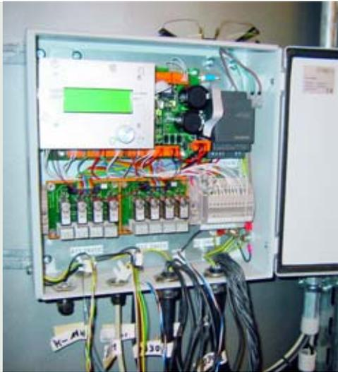
dardmäßig in einem Stahlblechgehäuse geliefert, in dem Netzteil, Grenzwertrelais und Anschlussblock untergebracht sind. (Kundenspezifische Varianten sind möglich). Das Brosa-System-Configurations-Tool (BSCT) ermöglicht dem OEM-Anwender komplexe Projektierungen am PC zu entwerfen und anschließend via serieller Schnittstelle (RS-232) auf das System zu laden. Das interne Dot-Matrix-Display Typ 0682 besitzt vier Zeilen mit je 20 Zeichen
